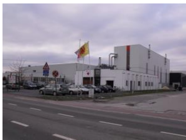
Bâtiment industriel au nord de la rue de Rochefort
