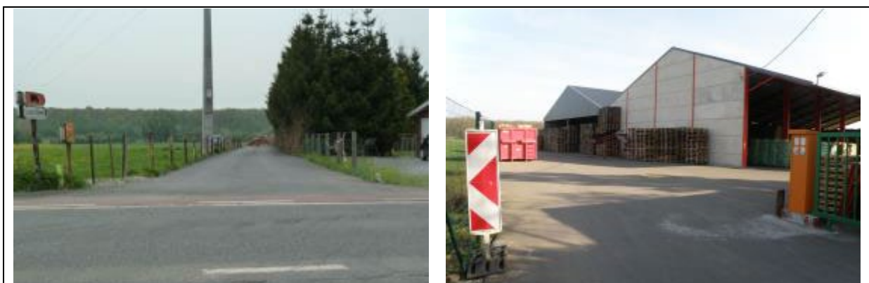
Voirie d'accès depuis la route de Rochefort à l'aire de stockage de bois
